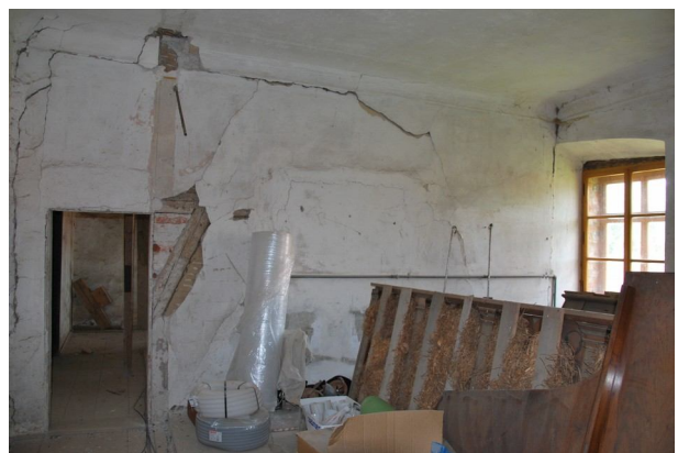
Rekonstrukce prostor 3. NP
