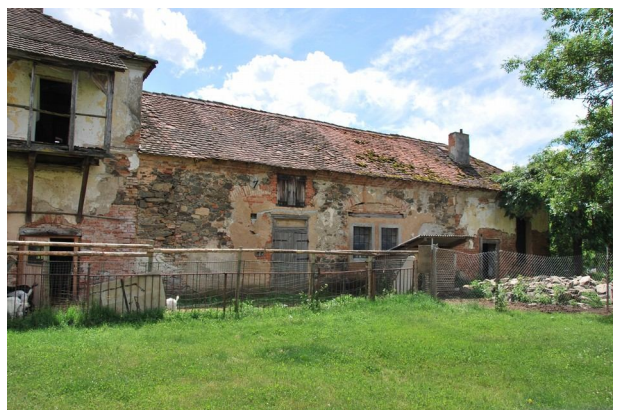
Rekonstrukce hospodářských budov
