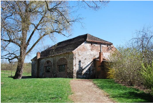
Rekonstrukce hospodářských budov
