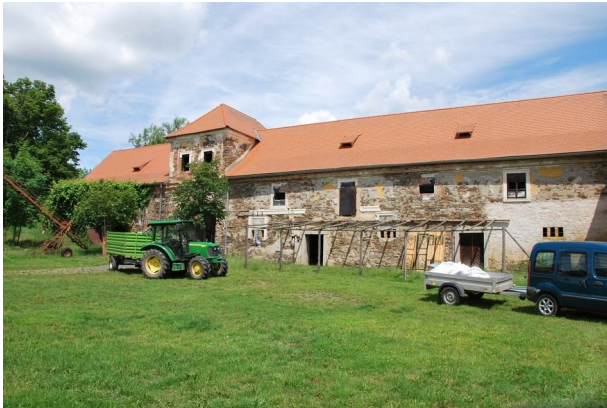
Rekonstrukce hospodářských budov
