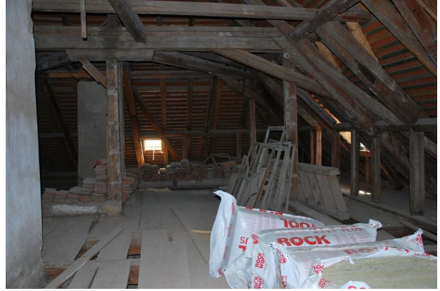
Rekonstrukce 3.NP půda východ
