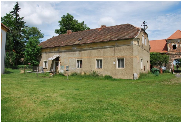
Rekonstrukce střechy domu správce
