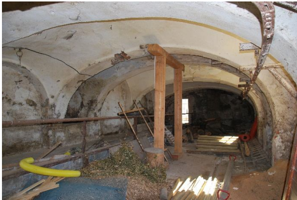
Rekonstrukce hospodářských budov
