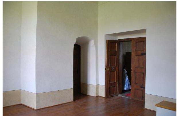
2. NP východ restaur. sál se schody
