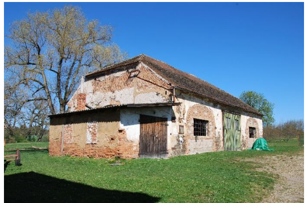
Rekonstrukce hospodářských budov
