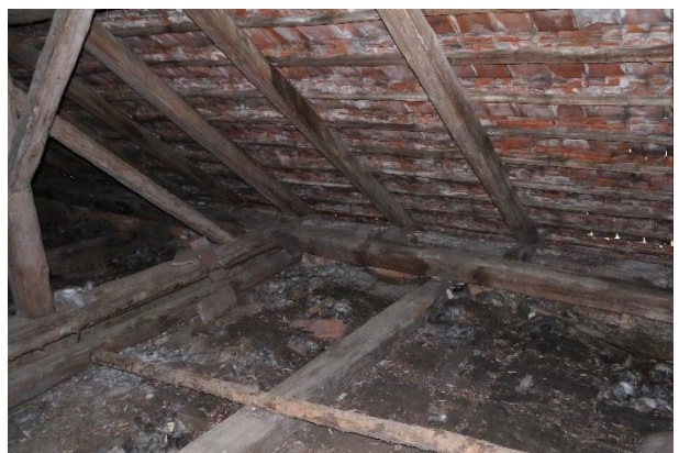
Rekonstrukce hospodářských budov
