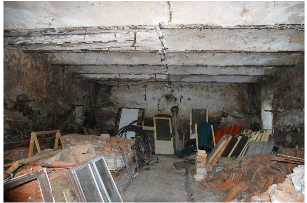
Rekonstrukce hospodářských budov
