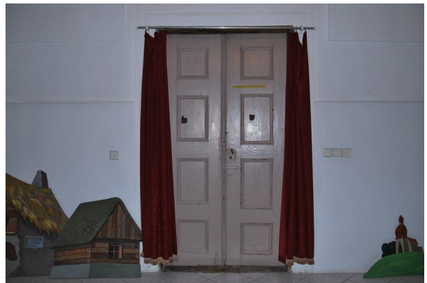
Obnova dveří v 1. NP východ
