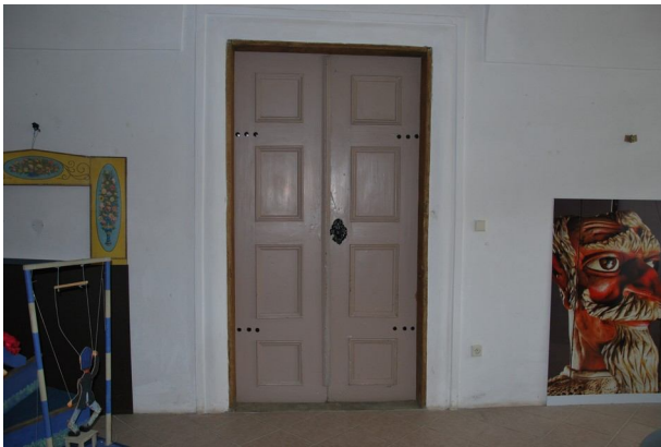
Obnova dveří v 1. NP východ
