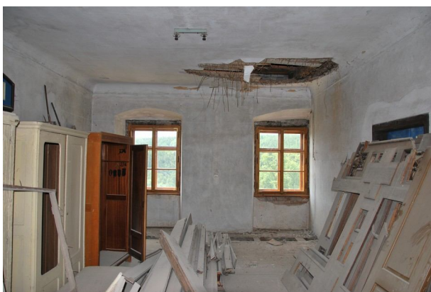
Rekonstrukce prostor 3. NP
