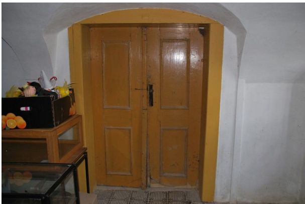
Obnova dveří v 1. NP východ
