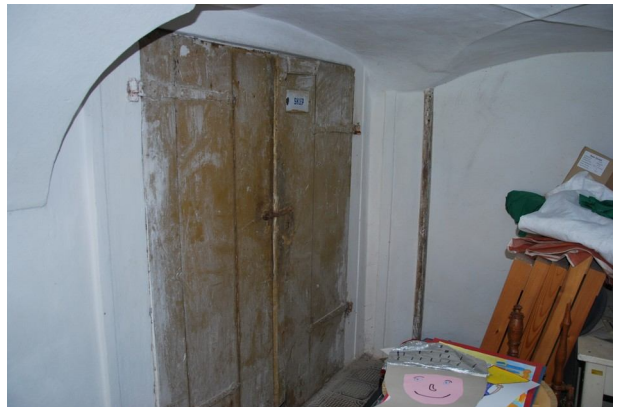
Obnova dveří v 1. NP východ
