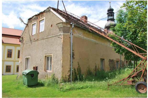
Rekonstrukce střechy domu správce
