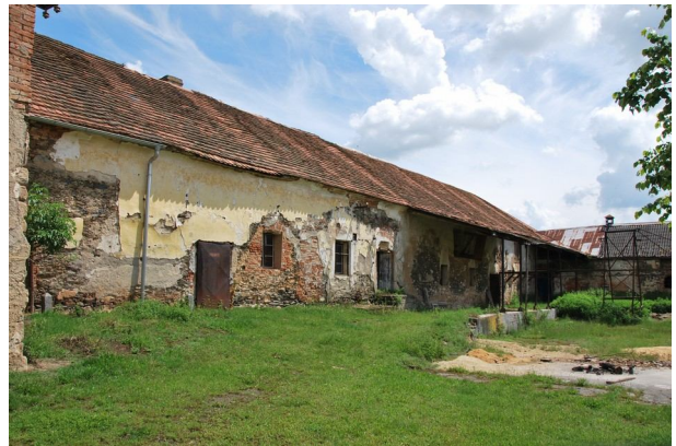
Rekonstrukce hospodářských budov
