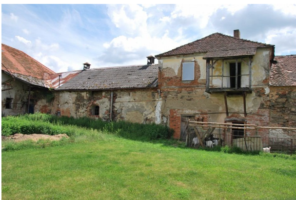
Rekonstrukce hospodářských budov
